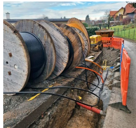
Einmal aufgraben für mehrere Zwecke: Baustelle in Muggauberg
